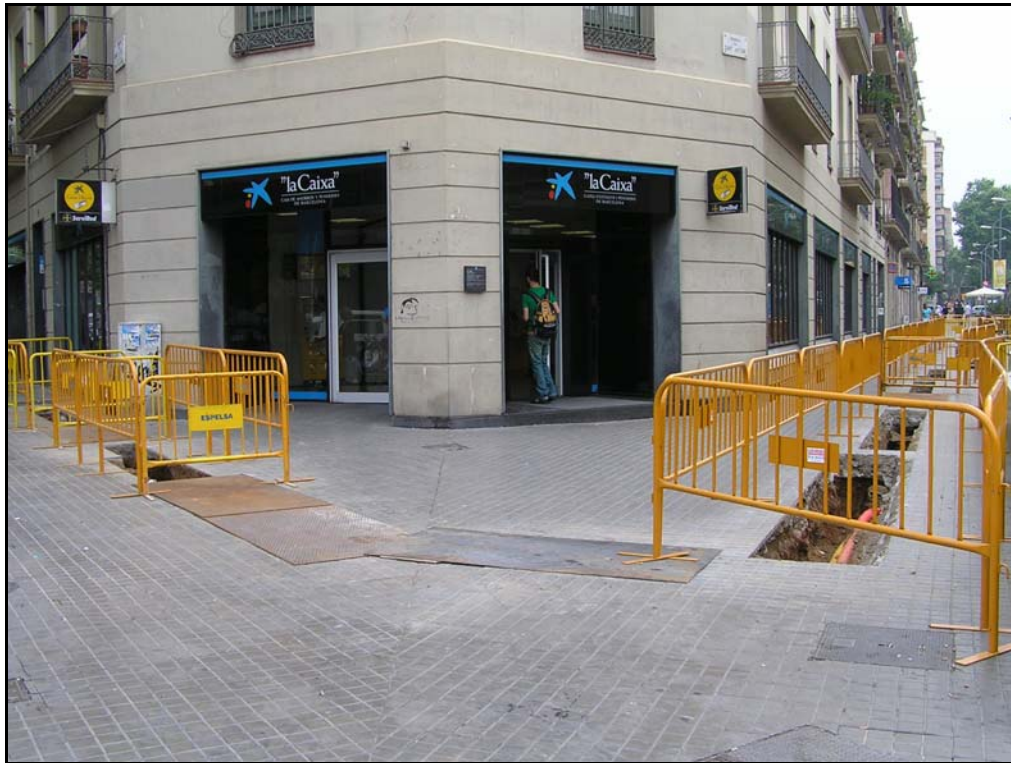
Foto 1. Situació de la rasa 1 en el C/Comte Urgell 2-4 i Rda. St. Antoni 1-5
