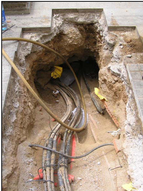
Foto 9. Rasa 2 en el tram de connexió amb la rasa 1
